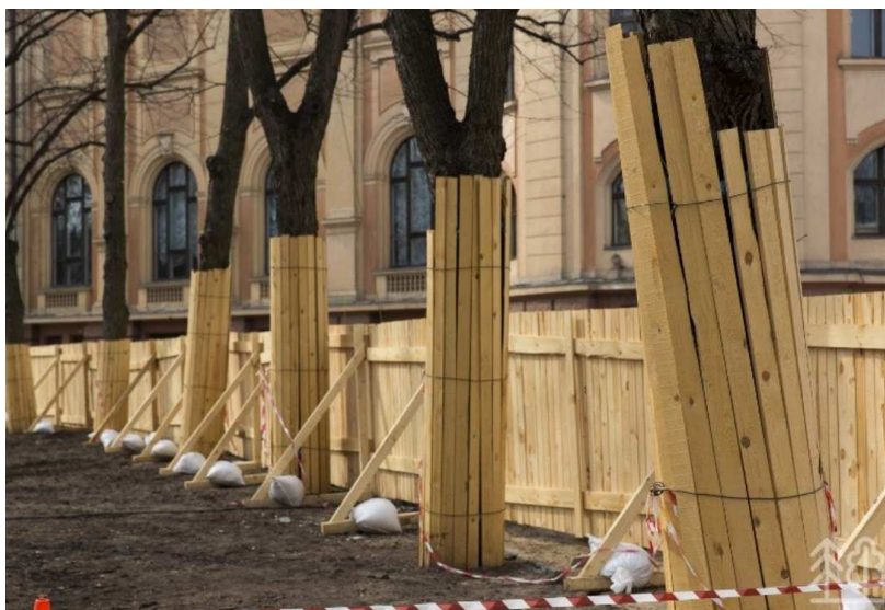
2.attēls. Piemērs koku aizsardzībai būvdarbu laikā
